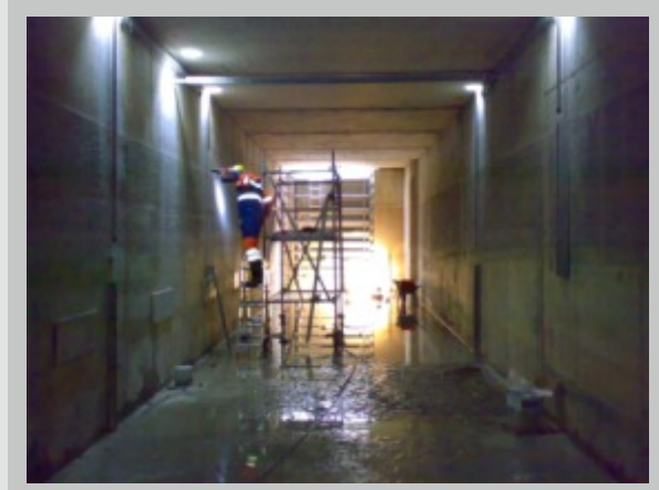
Montage der Sensoren im Kanal
